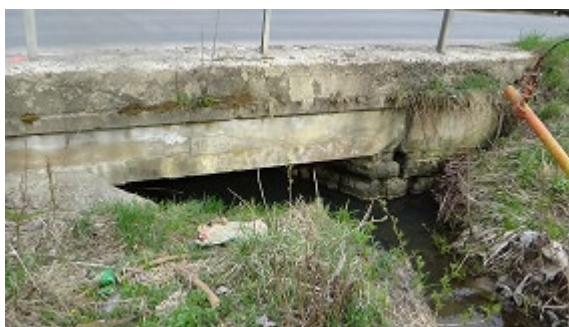
Stav mosta zo dňa 27.4.2021
