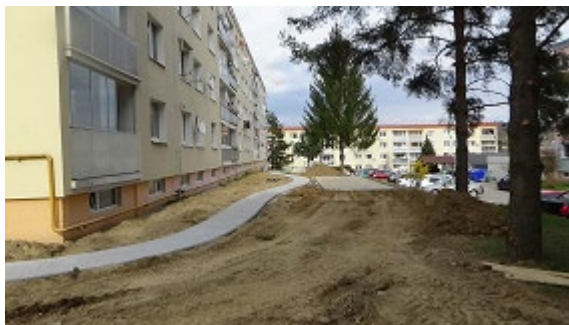
Stavba revitalizácie vnútrobloku zo dňa 27.4.2021
